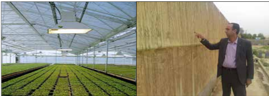
شکل ۲ - نصب سیستم سایه اندازه و رنگ آمیزی پوشش دیواره گلخانه برای تنظیم دمای داخل گلخانه
