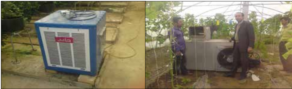
شکل ۱ - سیستم قدیمی تنظیم دمای داخل گلخانه (کولر و بخاری)
