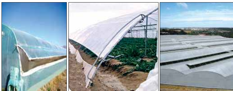
شکل ۱۰ - سیستم طبیعی تهویه در سقف و دیواره جانبی برای تنظیم دمای داخل گلخانه
